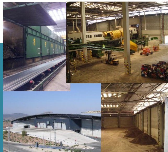
Planta de tractament de residus sòlids urbans. Villena
